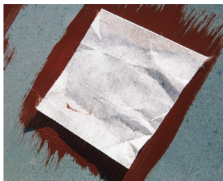
3. Армируем тканью "Elastomeric Fabric"
