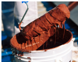
5. Покрываем всю площадь в 2 слоя
